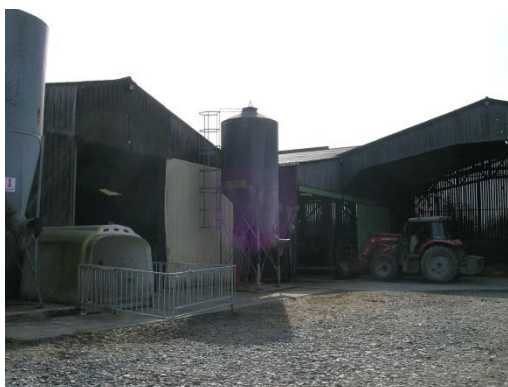
Exploitation agricole, Lieu-dit L’Église (Source: PLANIS, Etude de terrain, Mars 2015)
