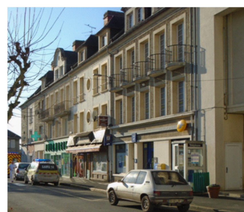
Ancien noyau de ville de Trévières
