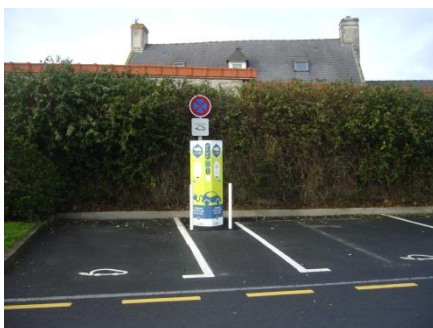
Borne de recharge et places dédiées à Isigny-sur-Mer
