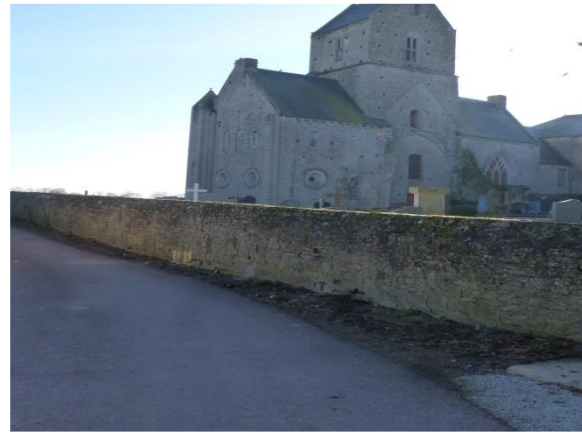
Absence de cheminement piéton dans le bourg, Deux-Jumeaux
