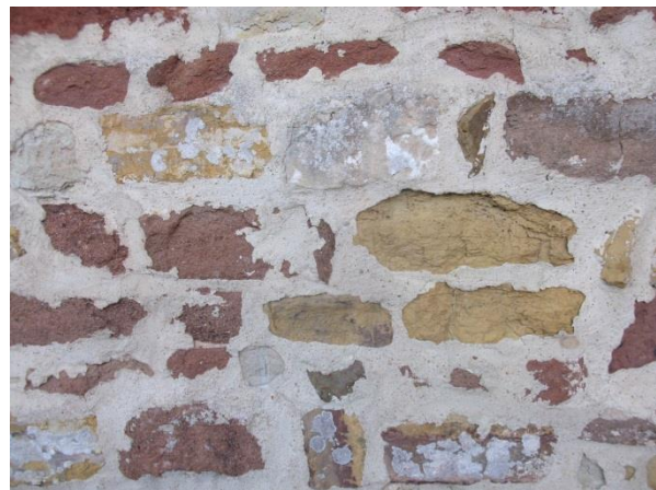
Pierres rouges et pierres calcaires sur les murs de l'église de Cartigny l'Epinay
