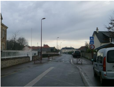
Rétrécissement de voirie et plateau piétonnier à Lison
