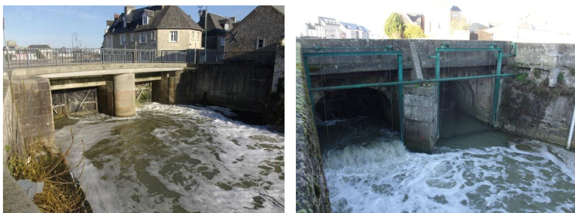
Les portes à flots sur l'Aure dans le port d'Isigny-sur-Mer, source : Planis
