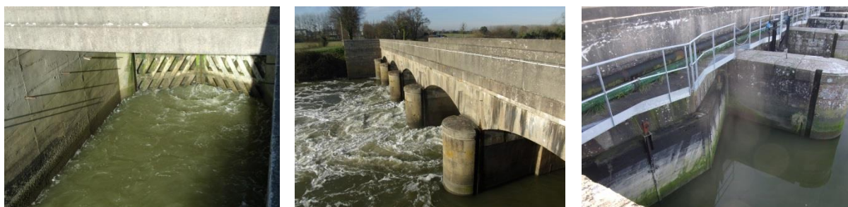
Les portes à flots sur la Vire, source : Planis
