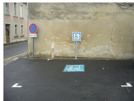
Place GIG-GIC non conforme au cimetière allemand de La Cambe
