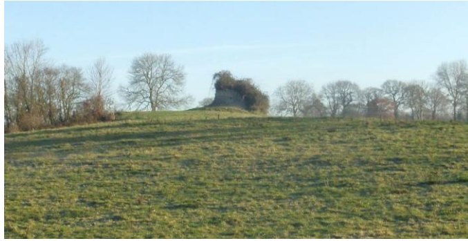
Ancien four à chaux de Cartigny l'Épinay, source : DREAL Normandie
