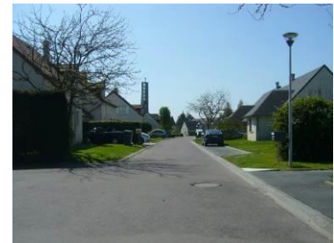
Voirie dans un lotissement à Grandcamp-Maisy
