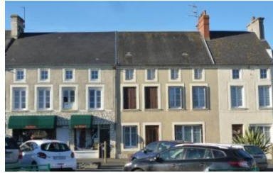
Maisons alignées et homogènes R+1+ combles. Typiques au niveau des combles avec des fenestrons carrés accolés à l'égout du toit. L'entourage béton des ouvertures laisse à penser à une rénovation, voire une reconstruction lors de la Reconstruction.
