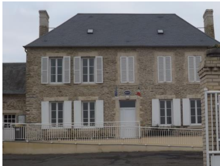
Rampe d'accès PMR à la mairie de Cahagnolles
