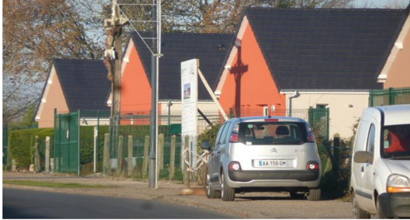
Stationnement anarchique sur un cheminement piéton à Sainte-Marquerite d'Elle
