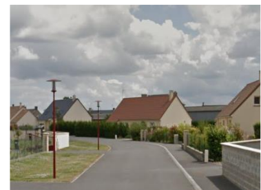
Voirie dans un lotissement à Noron la Poterie
