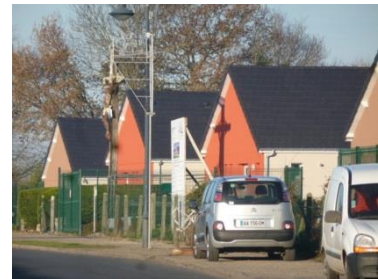
Habitat individuel groupé à Sainte Marguerite d'Elle. Densité : 22 logts/ha Hauteur : R ou R+1 Implantation : en cour avec pignon sur la route Espaces extérieurs : jardins de 100 à 200m 2 Espaces communs : cour technique avec parking et station d'assainissement.
