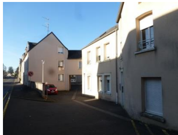
Immeuble collectif au Molay-Littry, route de Tournières Densité : 130 logts/ha Hauteur : R+1 ou R+1+combles Orientation Ouest/Est (avec les façades exposées au Sud mais parfois ombragées par le bâti situé de l'autre côté de la rue) Implantation : à l'alignement sur rue Espaces communs : parkings enrobés
