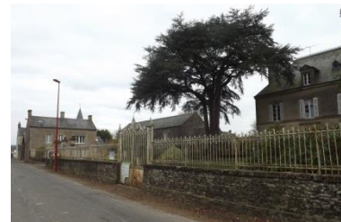
Saint-Paul-du-Vernay : Pignon sur rue, alignement ou recul du bâti qui donne à voir sur cours et parcs.
