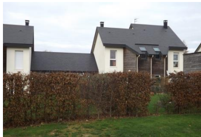
Habitat individuel groupé à Balleroy. Densité : 21 logts/ha Hauteur : R+1 Implantation : en bande Espaces extérieurs : jardins en lanières de 150m 2 Annexes : garages
