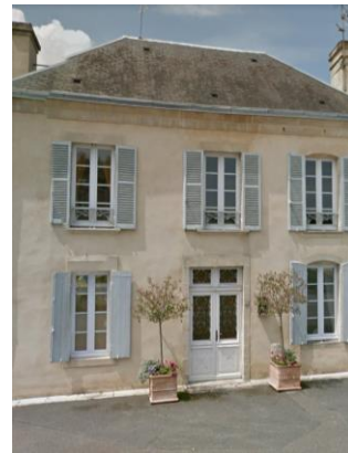
Façade en enduit traditionnel à la chaux à Trévières
