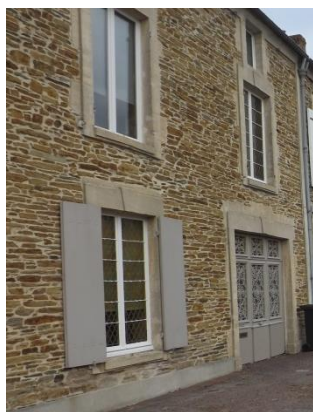
Façade en schiste à Balleroy-sur-Drôme
