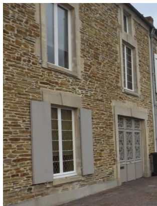
Façade en schiste à Balleroy-sur-Drôme
