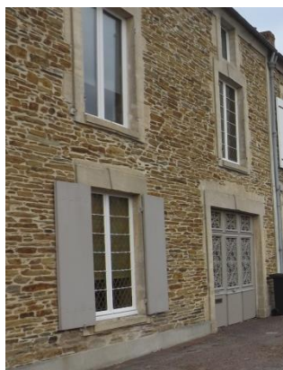
Façade en schiste à Balleroy-sur-Drôme
