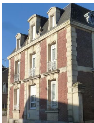
Façade en briques de terre cuite dont certaines sont vernissées au Molay-Littry
