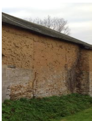
Mur en terre crue au Molay-Littry
