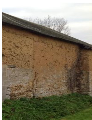
Mur en terre crue au Molay-Littry
