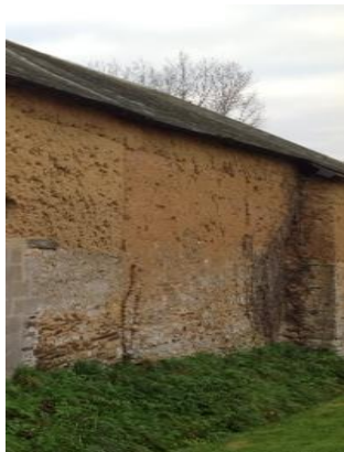
Mur en terre crue au Molay-Littry
