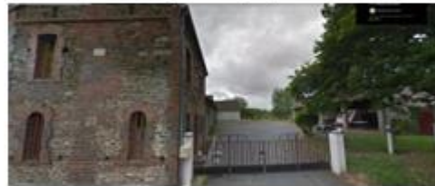
A gauche : habitation qui servira de logements pour les salariés
