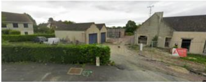
Bâtiment des services techniques au centre
