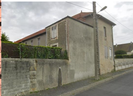
Bâtiment à détruire
